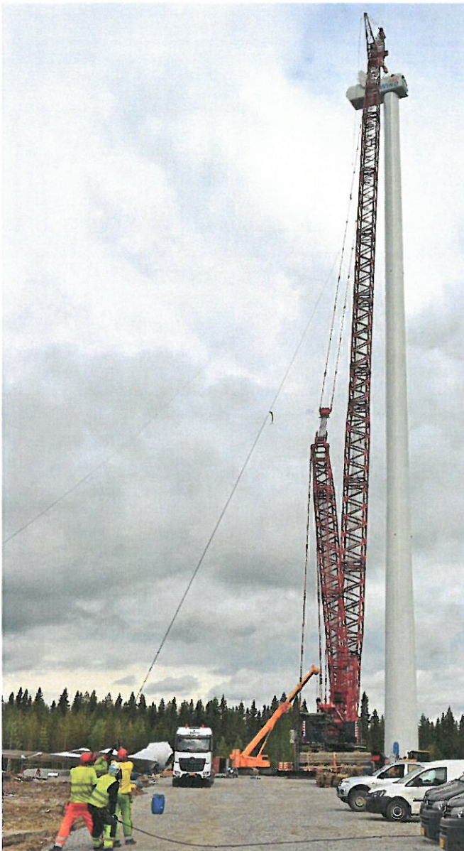
Ensimmäiset tuulivoimalat pystytettiin Haapajärvelle kesällä 2015
