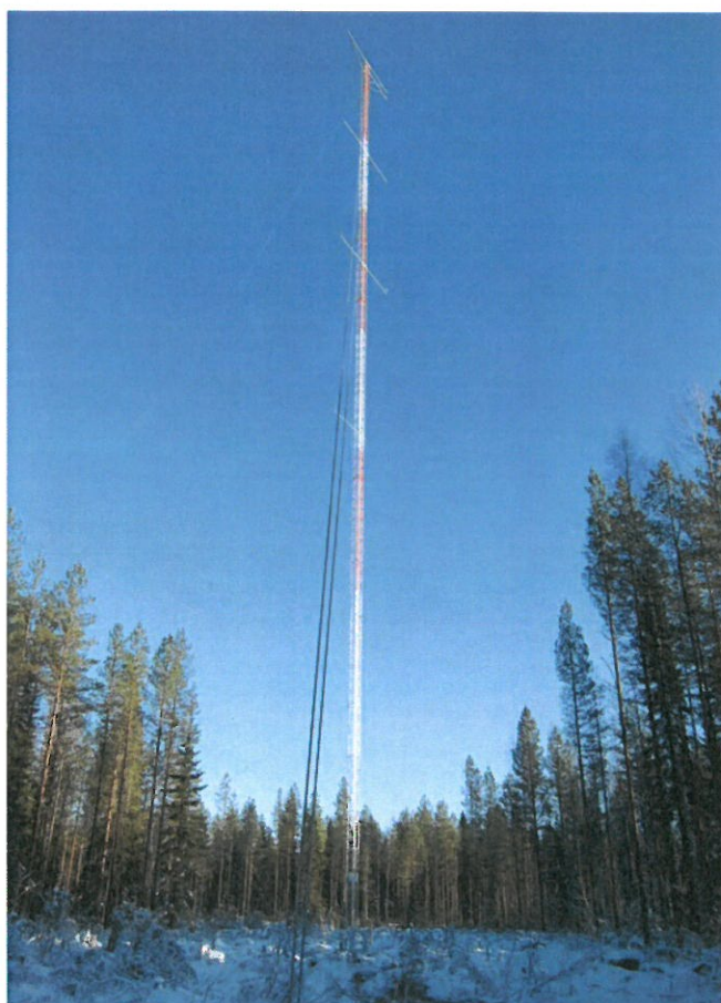
Hyvät tuuliolosuhteet varmistetaan tuulimittausten avulla. Kuvassa tuulimittaustasto Pyhäjoella marraskuussa 2013.
